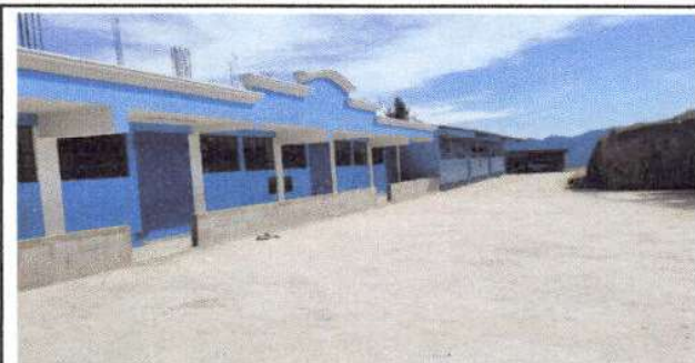
Foto 3: Sustrucion de piso de torta de concreto en el Patio de la Escuela
