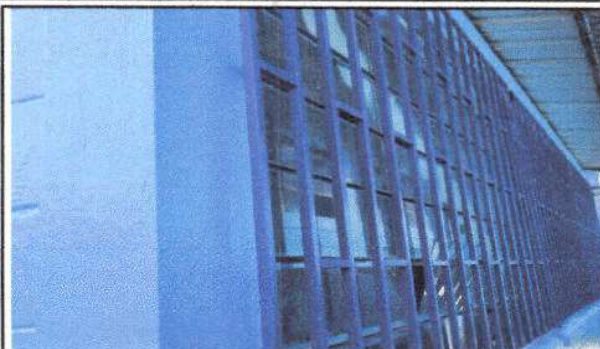
Foto 2: Instalacion de vidrios y balcones mudulo direccion
