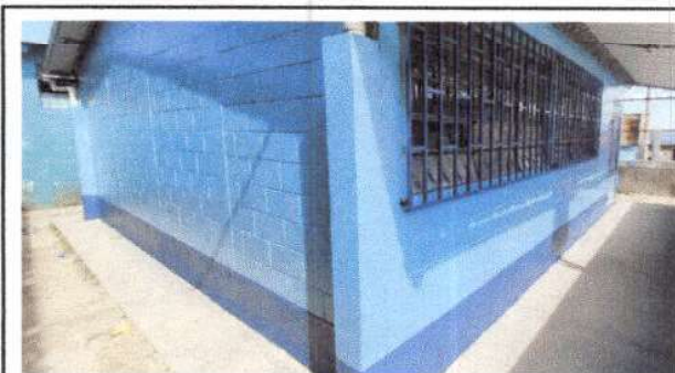
Foto 4: pintura en muros exteriores
