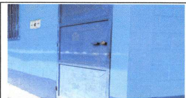
Foto 5: Instalacion de chapas nuevas
