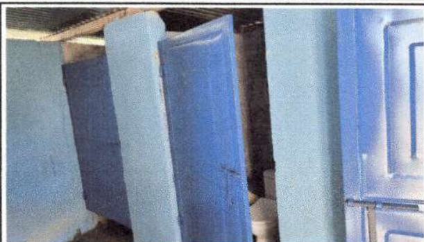
Foto 1: Sustrucion de Puertas de baños
